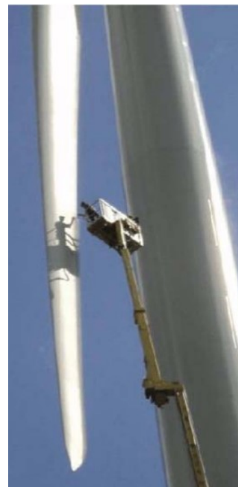
Figur 2 - "Hajtänder" skruvas på verk i Laholms kn för att akut lösa bullerproblem 70 .
