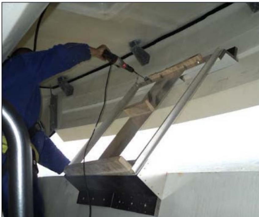
Figur 2 - "Hajtänder" skruvas på verk i Laholms kn för att akut lösa bullerproblem 70 .
