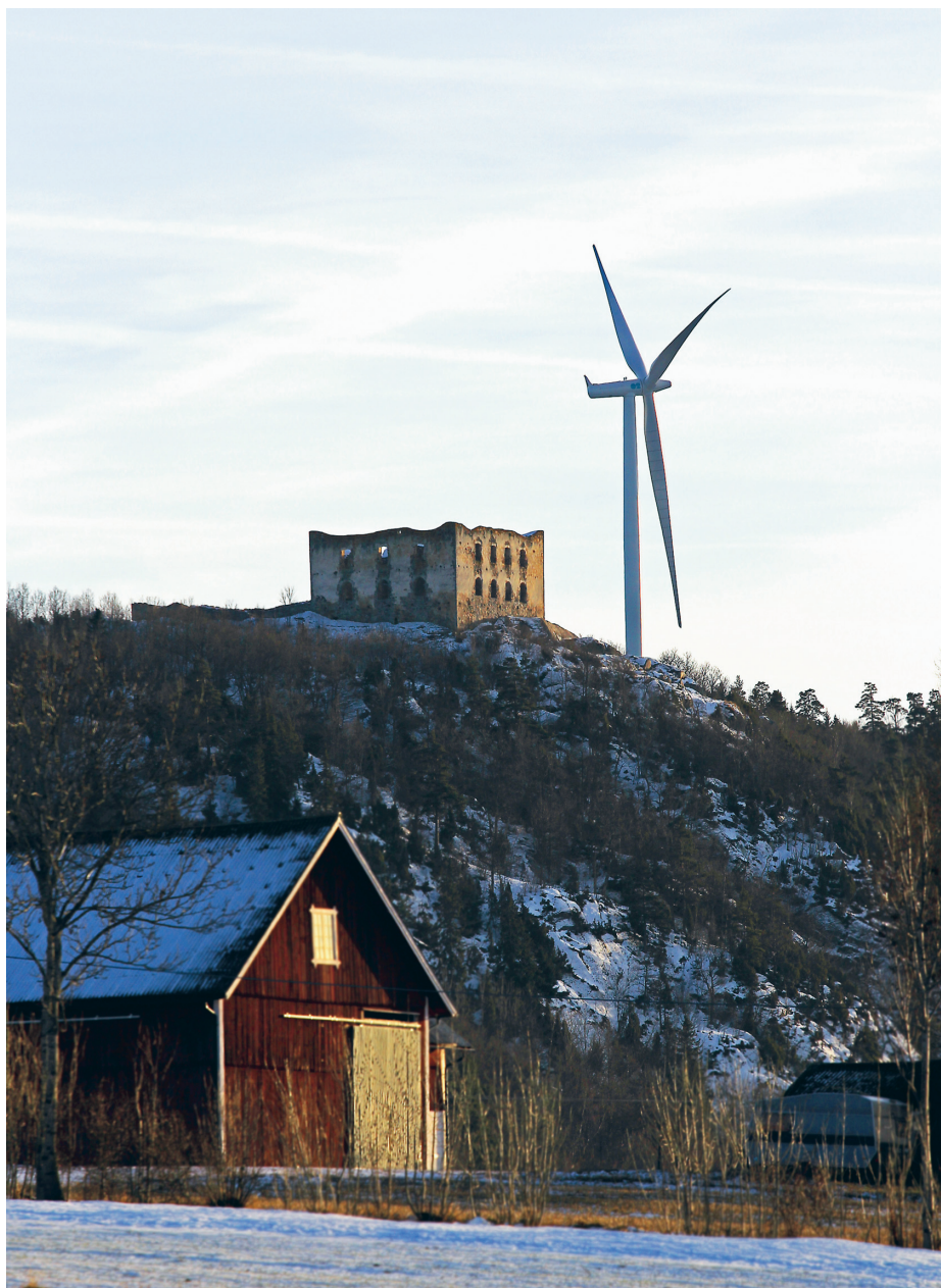
Bild 1: Vindkraftverk intill Brahehus, Gränna.
